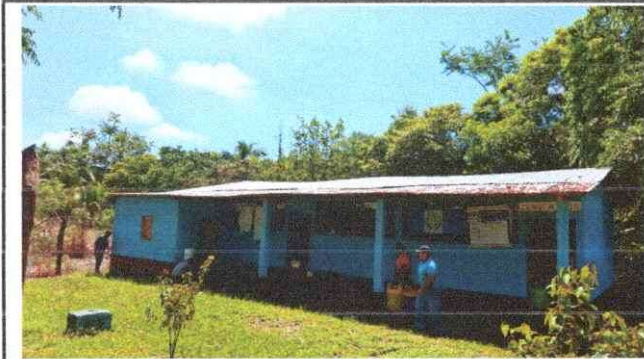
Foto 1: SUSTITUCION DE CUBIERTA DE LAMINA EN MAL ESTADO
