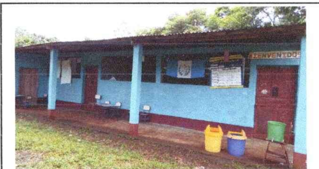
Foto 6: SUSTITUCION DE PUERTAS DE METAL Y MADERA
