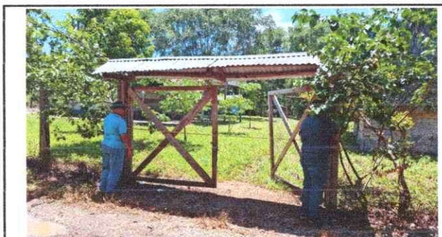
Foto 5: SUSTITUCION DE PORTON DE MADERA POR PORTON DE MALLA CON TUBO GALVANIZADO
