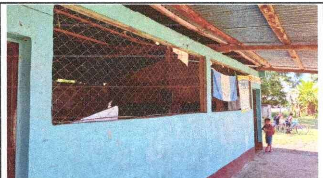
Foto 4: SUSTITUCION DE MALLA. POR BALCON
