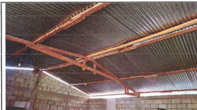
Foto 3: SUSTITUCION DE ESTRUCTURA DE MADERA POR METAL
