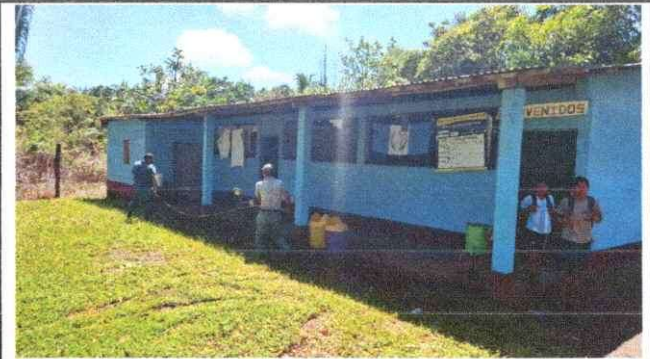
Foto 2: PINTURA EN EXTERIOR E INTERIOR
